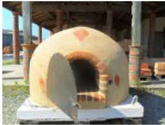
Liste des produits nécessaires à la fabrication d'un four à pain : Brique Tradition 3x11x22, sole de four, terre broyée et brique pilée
